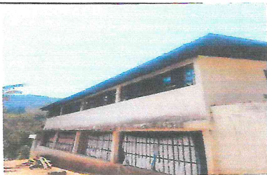
Foto 5: Pintura en muros exteriores e interiores.
