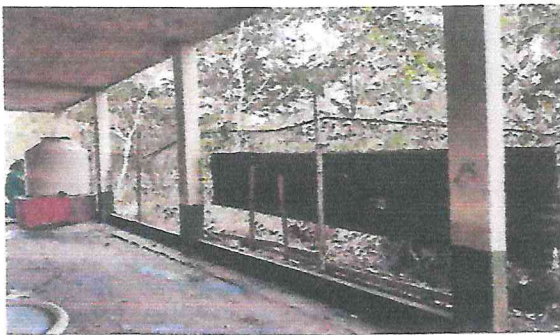
Foto 3: sustitución de muro de malla y block por muro de hierro y block
