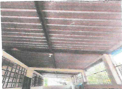
Foto 1: Sustitución de lamina por lámina troquelada
